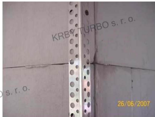
20. Pokud máte na krbu pravý úhel, použijte pro zpevnění hliníkový roh, kterým překryjete stávající z desek Silca.
