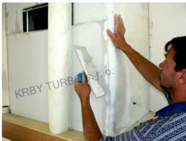
19. Perlinka se aplikuje standardním způsobem. Silcatex-SE přiložíte na desky a přetáhnete kamnářským lepidlem (doporučujeme kamal 10) pro rychlý postup monáže. Toto lepidlo vytvrdne cca za 15 min - v závislosti na okolní teplotě.
