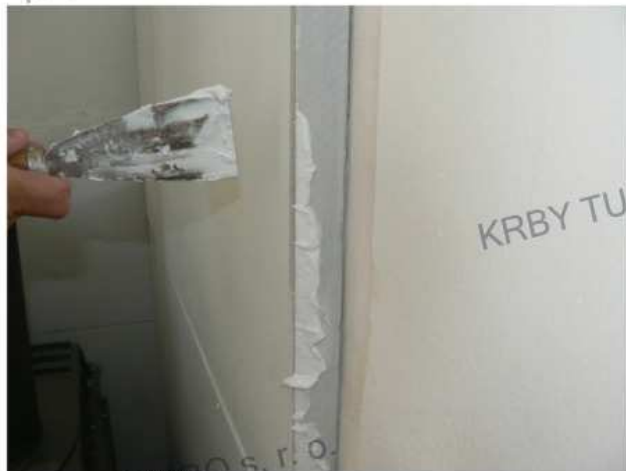
17. Lepidlo z kartuše si můžete vymáčknout do připravené nádoby a nanášet špachtlí, nebo používat lepidlo ve verzi v kyblíku a nabírat přímo z něj. Nezapomínat na promýchání v kyblíku, nebo prohnětení kartuše.
