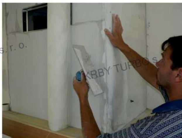
24. Můžete začít s aplikací kamnářského lepidla a později kamnářské omítky.
