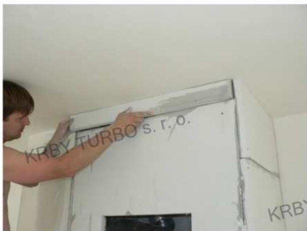
21. Připravený díl taktéž instalujete pomocí vrutů a lepidla.
