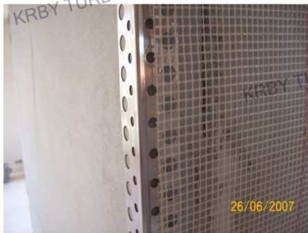
21. Přiložíte Silcatex-SE a natáhnete lepidlo.
