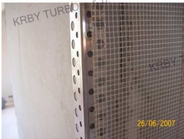
23. Pro zpevnění rohu s pravým úhlem použijte hliníkový profil.
