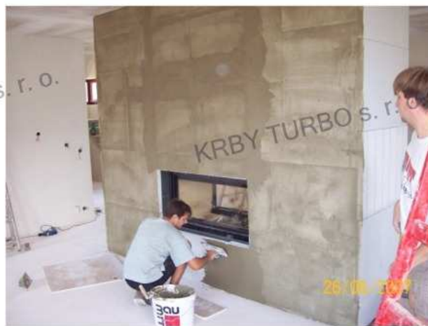
22. Po zaschnutí lepidla nanese vrstvu kamnářské omítky (doporučujeme kamal MOD). Doba tuhnutí cca za 30 min - v závislosti na okolní teplotě.
